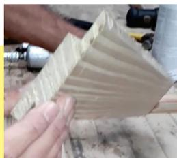
**Atenção:** Quando o painel for ser instalado no sentido horizontal, cuidar para que o encaixe das peças, fique para o lado de cima da parede, para que a água da chuva não acumule no encaixe.
